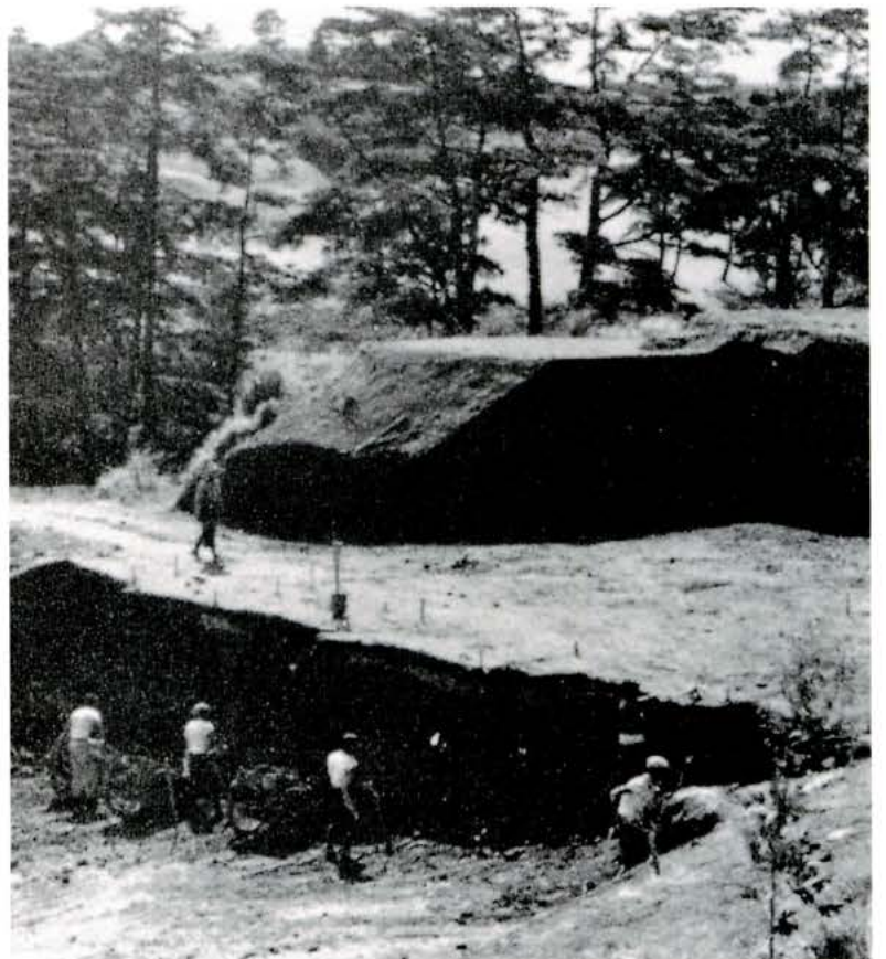
リヤカーで土を運ぶ (川崎国際カントリー倶楽部切土工事)
