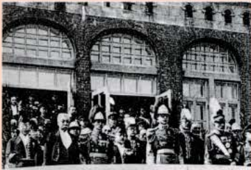
満州国建設（昭和7年3月1日）
