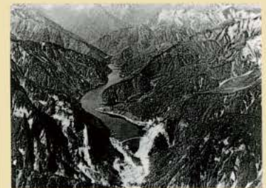
黒四ダム完工 (昭和38年6月5日)
