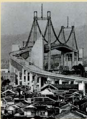
若戸大橋完成 (昭和37年9月29日)
